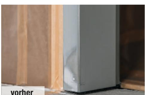
Dank der rostinhibierenden Wirkung lässt sich Herbol Protector Duraspray bei kleinen Schäden ohne zusätzliche Grundierung direkt auf das an diesen Stellen rohe Metall einsetzen (Spot-Repair).
