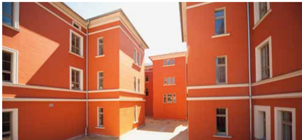
Die rissige Fassade wurde mit den aufeinander abgestimmten Herbol-Herboflex-Produkten saniert.
