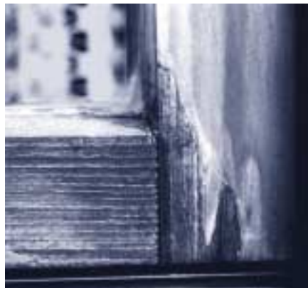
Ein stark beschädigtes Fenster durch nicht ausreichende Verleimung.
