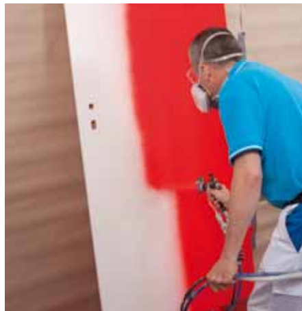
5. Erst werden die Randbereiche, dann die Türfläche in einem Kreuzgang lackiert.
