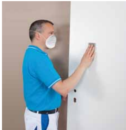
2. Bei der Vorbehandlung muss die Fläche geschliffen und entstaubt werden.
