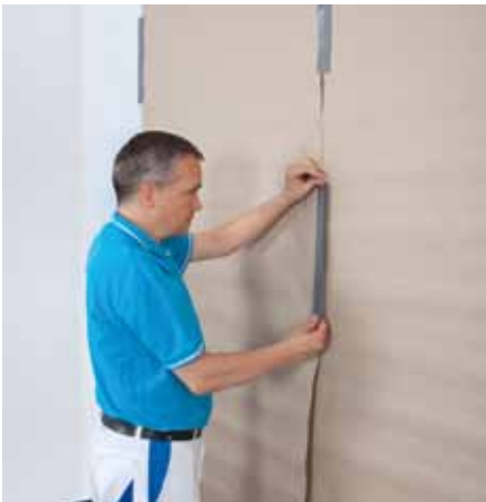
1. Die Umgebungsflächen werden mit geeignetem Material abgedeckt.
