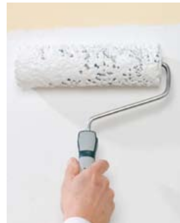
Nach der vollständigen Trocknung von Herbol-Fungimos Schimmelreiniger 1 erfolgt eine zweimalige Beschichtung mit Herbol-Innenweiß Schimmelschutz
