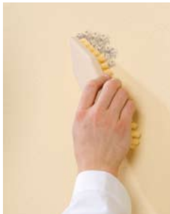
Schimmelbelag durch Nassreinigung gründlich mit Bürste und lauwarmem Wasser entfernen
